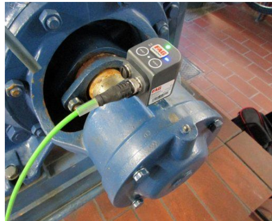
شکل (2) - اندازه‌گیری دمای بیرینگ جهت جلوگیری از آسیب در صورت افزایش بیش از حد دما
